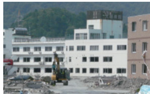
2階部分まで津波の被害を受けて廃墟と化した岩手県立大槌病院(2011年6月22日、同県大槌町)
